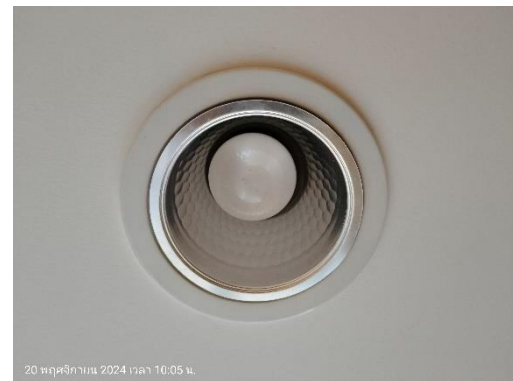
หลอดไฟชนิดประหยัดพลังงานและ โคมไฟสะท้อนแสง
