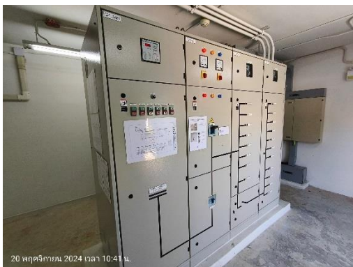
Main Distribution Board อาคารละ 1 ชุด
