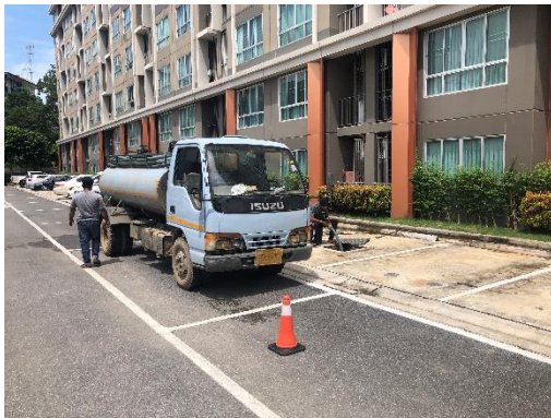
ตุดำจัดจัดตะกอนระบบบำบัดน้ำเสีย
