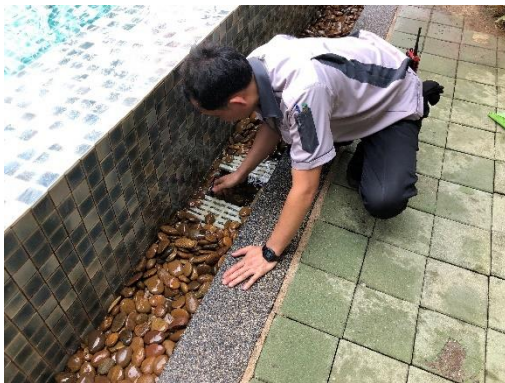
ตรวจสอบท่อระบายน้ำและชุดลอกตะกอนดิน
