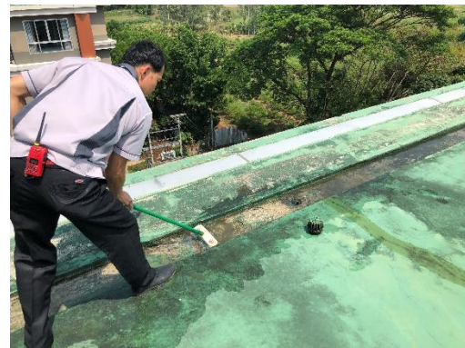
ตรวจสอบท่อระบายน้ำและชุดลอกตะกอนดิน
