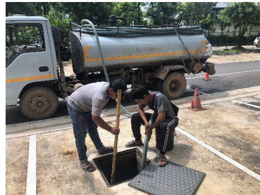
ตุดำจัดจัดตะกอนระบบบำบัดน้ำเสีย
